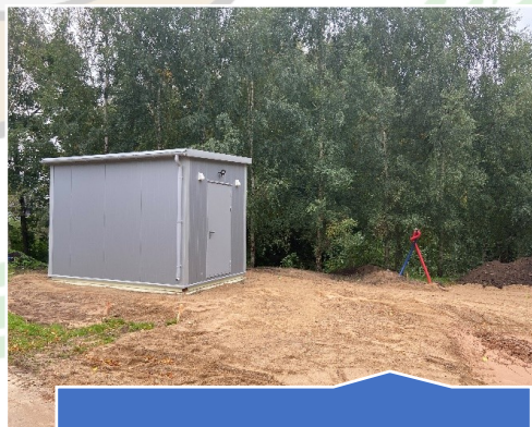
Po remonto darbų
