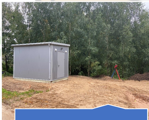
Prieš remonto darbus
